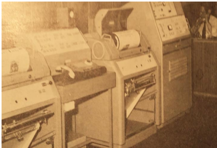
Urządzenie teletransmisyjne do przekazywania kolumn Trybuny Ludu do zakładów RSW „Prasa - Książka - Ruch” we Wrocławiu.
