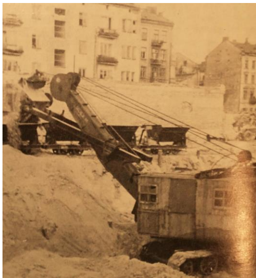
W przygotowanych wykopach pod fundamenty ukazała się woda. Wydobywane zwały ziemi transportowano furmankami i wagonami-wywrotkami
