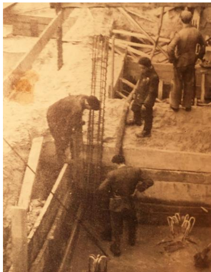
W przygotowanych wykopach pod fundamenty ukazała się woda. Wydobywane zwały ziemi transportowano furmankami i wagonami-wywrotkami
