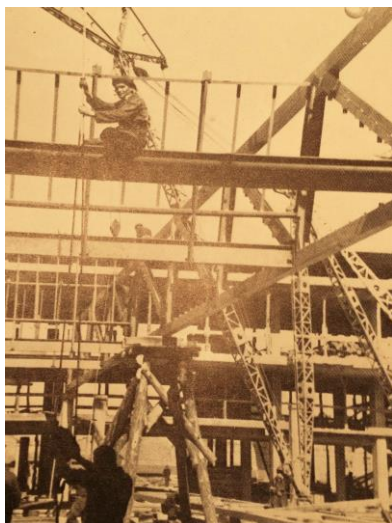
Nad halą produkcyjną monterzy tworzą sieć konstrukcyjną dachu
