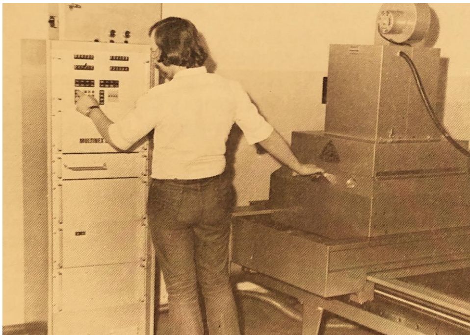
Sterowana przy pomocy programu maszyna do wielokrotnego kopiowania.
