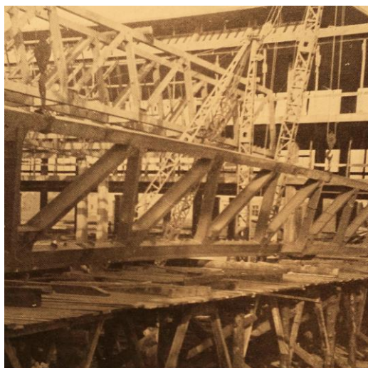
Nad halą produkcyjną monterzy tworzą sieć konstrukcyjną dachu
