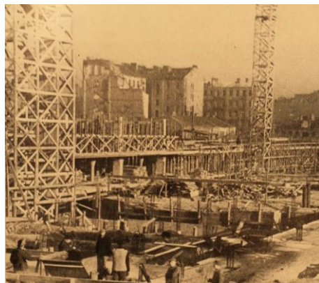
W wykopach fundamentowych rozpoczęto betonowani Dawny plac Kazimierza Wielkiego pokryły szalunki. Front robót świadczył o skali zamierzenia.
