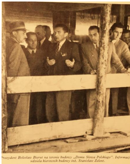
Prezydent Bolesław Bierut na terenie budowy "Domu Słowa Polskiego". Informacji udziela kierownik budowy inż. Stanisław Zelent.
