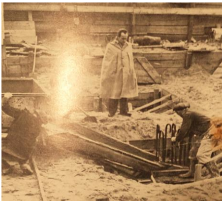
W wykopach fundamentowych rozpoczęto betonowani Dawny plac Kazimierza Wielkiego pokryły szalunki. Front robót świadczył o skali zamierzenia.
