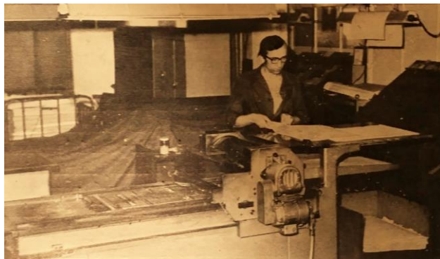
Prasa kontrolna typu "FAG-Control" do odbijania kolumn "Trybuna Ludu" dla celów teletransmisji.
