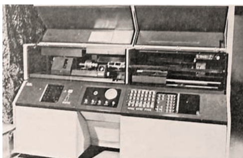
Magnascan 460 – urządzenie do elektronicznego wykonywania wyciągów barwnych z możliwością stosowania korekty poszczególnych kolorów.
