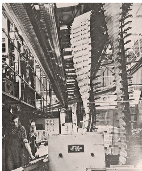
Typograficzna maszyna zwojowa typu WIFAG 60" do druku gazet.
