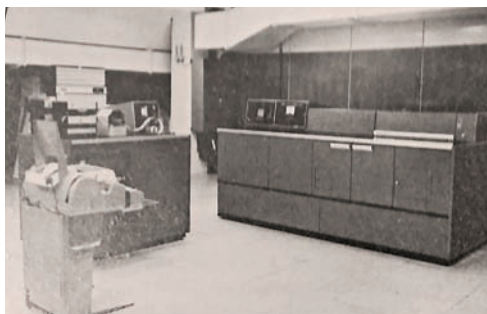
Urządzenie Linotron 505 Tc przeznaczone do szybkiego składu fotograficznego
