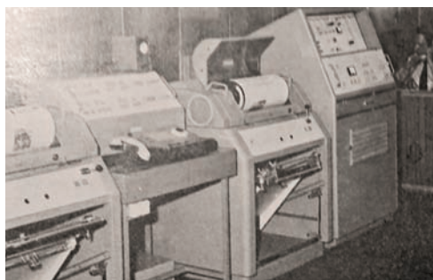
Urządzenie teletransmisyjne do przekazywania kolumn Trybuny Ludu do zakładów RSW „Prasa – Książka – Ruch” we Wrocławiu
